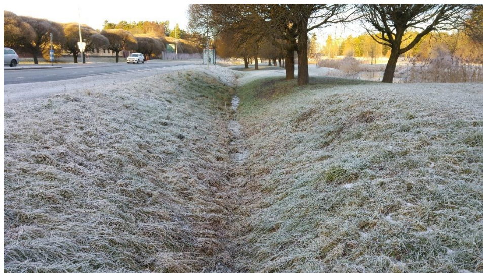
Exempel på ett klippt gräsdike.
