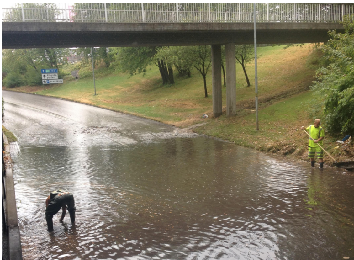
Översvämning p g a skyfall i augusti 2014. Uppdämt spillvatten samt yttlig avrinning orsakade källaröversvämningar och förstörda garage, ett betydande antal människor påverkades. Med rätt dagvattenlösningar kan vi bidra till att minska framtida översvämningar. Foto Kretsloppsavdelningen.
