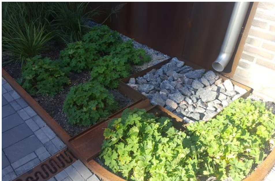
Öppen, grön hantering av takdagvatten i nedsänkt växtbädd. Dagvattnet renas och fördröjs innan avledning till dagvattennätet samtidigt som det används som resurs för bevattning av växter. Foto Sweco Environment.
